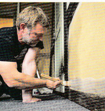
Zuerst an den Kanten ordentliche Übergänge schaffen, dann mit der Malerbürste im Kreuzgang die Fläche von oben nach unten streichen.
