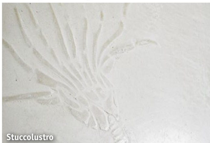
Motiv Kalkglätte, mit Sumpfkalkfarbe gefüllt überstrichen
